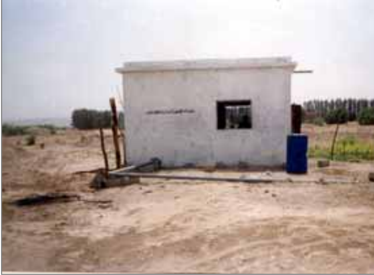
مبنى المولد الكهريائي لضخ مياه مشروع مياه لسان شنان
